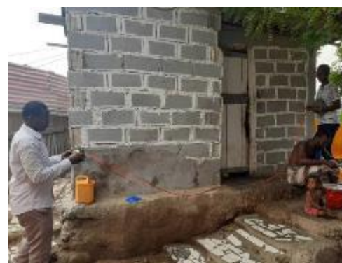
Photo 8 : évaluation des structures et équipements connexes
